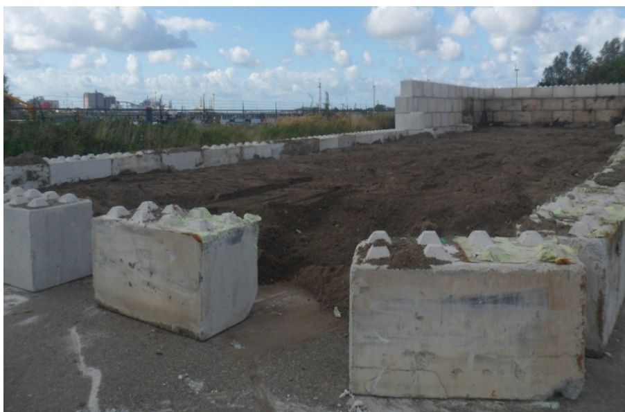
Figuur 15 Overzicht van het depot na uitspreiding van de grond in een laag van ca. 40-50 cm op asfalt ondergrond en afgezet met betonblokken om wegspoelen te voorkomen.
