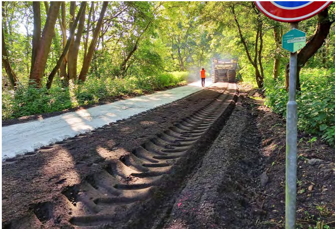
Figuur 4.1 Voorbeeld van tussentijdse aanlegsituatie bij Mix-in-Place.
